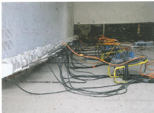
Spezialverfahren: Anlegen einer Horizontalsperre aus Paraffin, um die Durchfeuchtung der Wand durch aufsteigendes Wasser zu stoppen. *Isotec*
